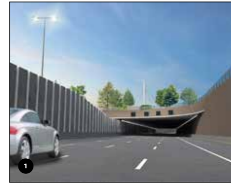
Verbreiding A9 Uitbreiding van de noordelijke en zuidelijk rijbaan van de A9 van drie naar vier rijstroken.
