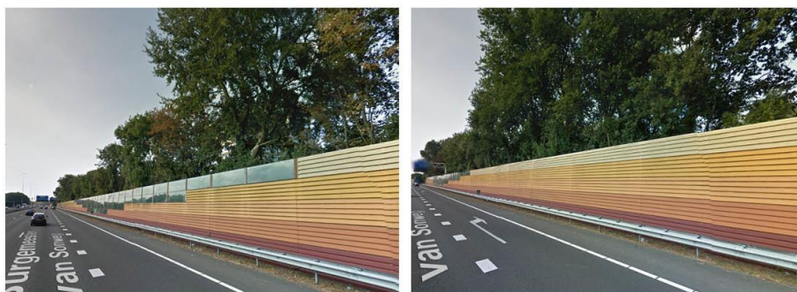
Geluidsschermen ca. +5 meter hoog t.o.v. snelweg A9 (ca. +10 m t.o.v. water Meanderpark)
