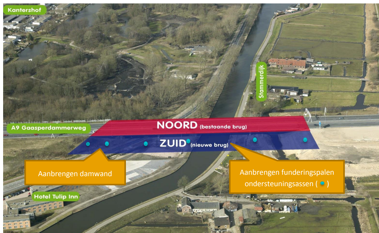
Afbeelding 1: Werkzaamheden brug over de Gaasp eind september en in oktober
