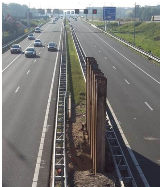
Afbeelding 1: de damwanden komen in de middenberm van de A9. Bij de Gooiseweg zijn er in het najaar al een paar geplaatst. Ze vormen ook de fundering voor de hulpbrug daar.
