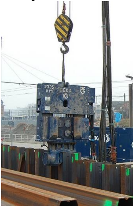
Afbeelding 3: IXAS gebruikt stalen damwanden die de grond ingebracht worden met een trilblok.
