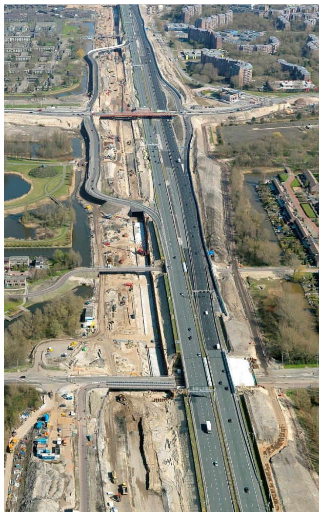
Afbeelding: links van de A9 ziet u een deel van de wisselbaan liggen. De komende weken wordt deze afgemaakt.
