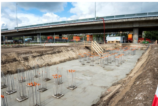
Stap 2: aanbrengen betonfundering
