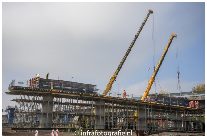
Stap 4: maken oplegbalken
