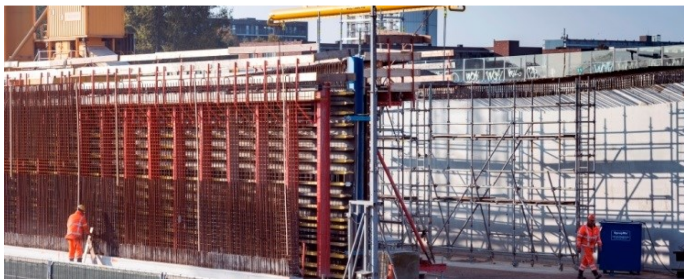
Afbeelding: ook bij de Kromwijkdreef wordt de tunnel zichtbaar: de eerste wanden staan er.
