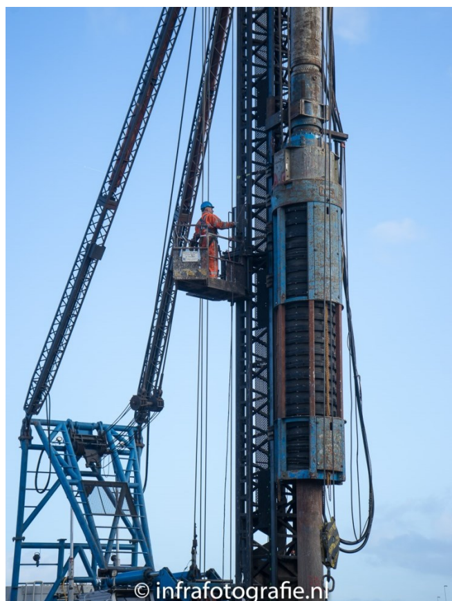
Afbeelding: naar verwachting gaat half februari de laatste heipaal voor de Gaasperdammertunnel ter hoogte van de wijken Kouwenoord en Kantershof de grond in.
