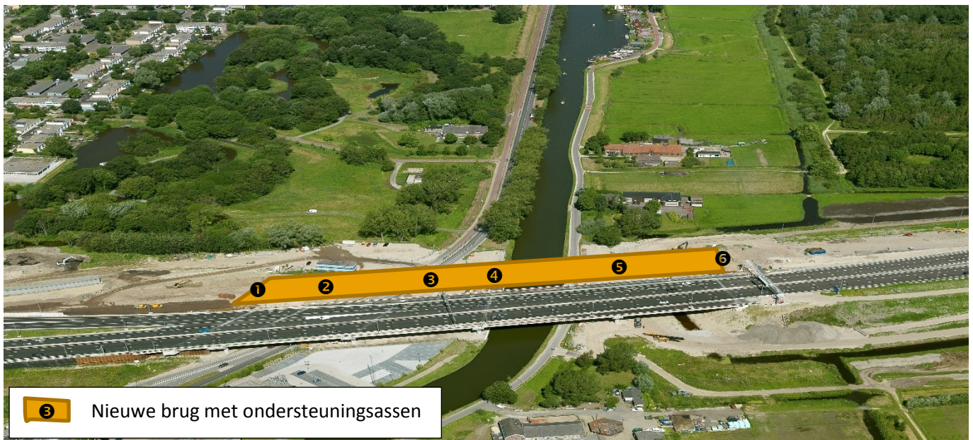
Afbeelding 1: Overzicht bouw tweede Brug over de Gaasp.
