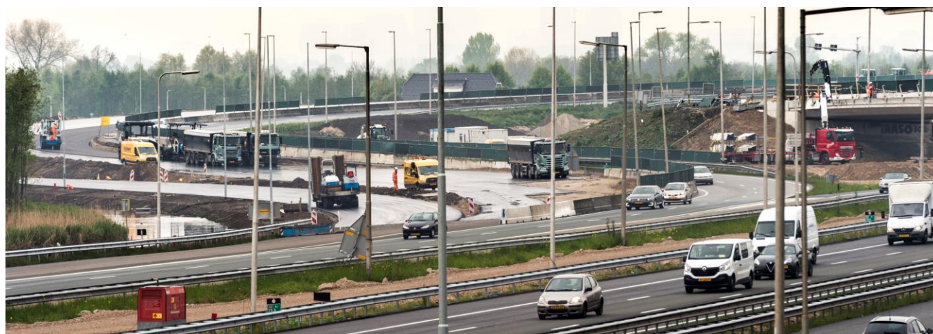
Afbeelding: de eerste asfaltlagen van de nieuwe verbindingsweg brachten we eerder al aan.
