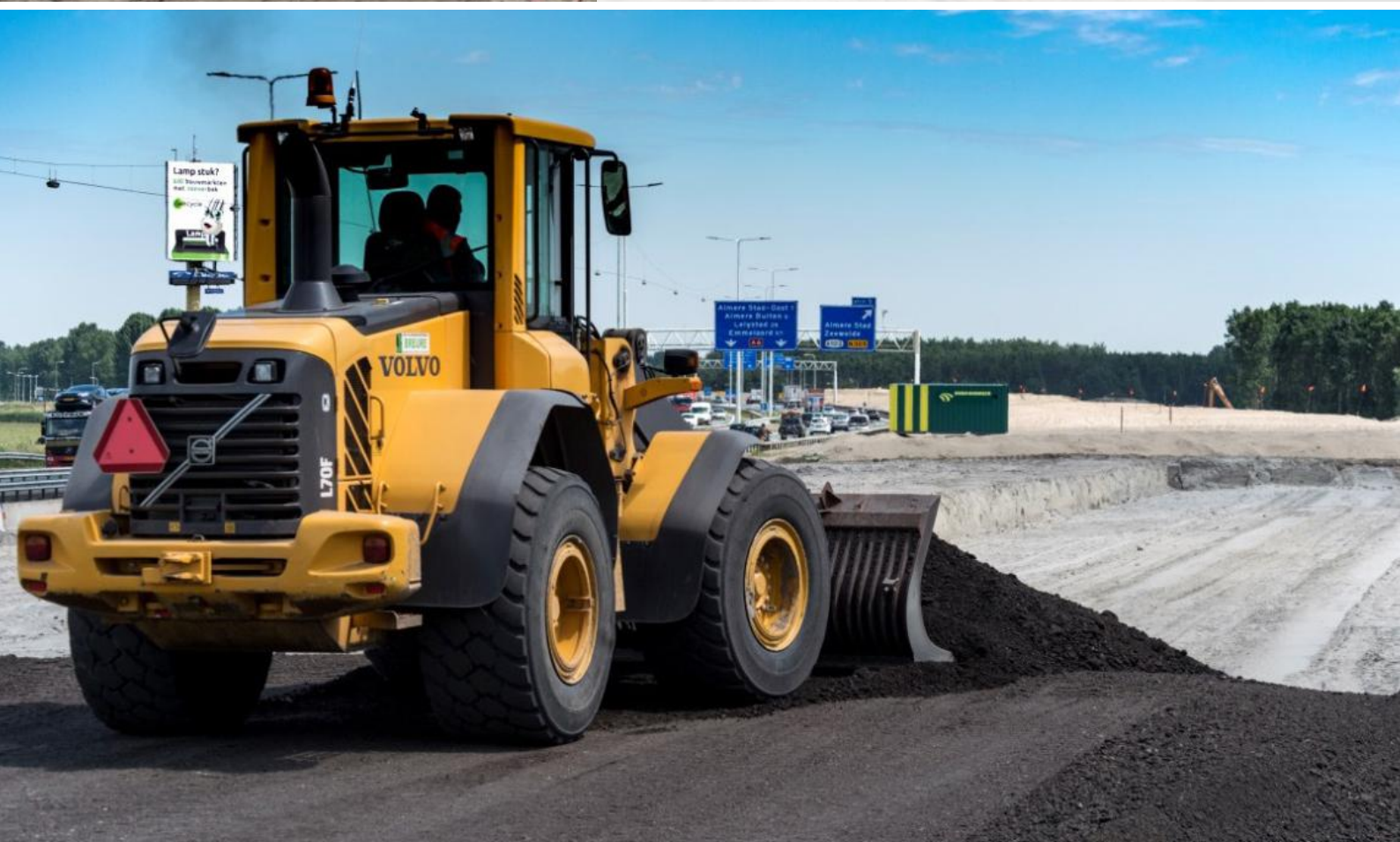
Aan de zuidkant van de toekomstige parallelrijbaan tussen Almere Havendreef en Almere Haven wordt een tijdelijke bouwweg aangelegd. Daardoor is het werk goed bereikbaar voor het bouwverkeer en op veilige afstand van het wegverkeer.
