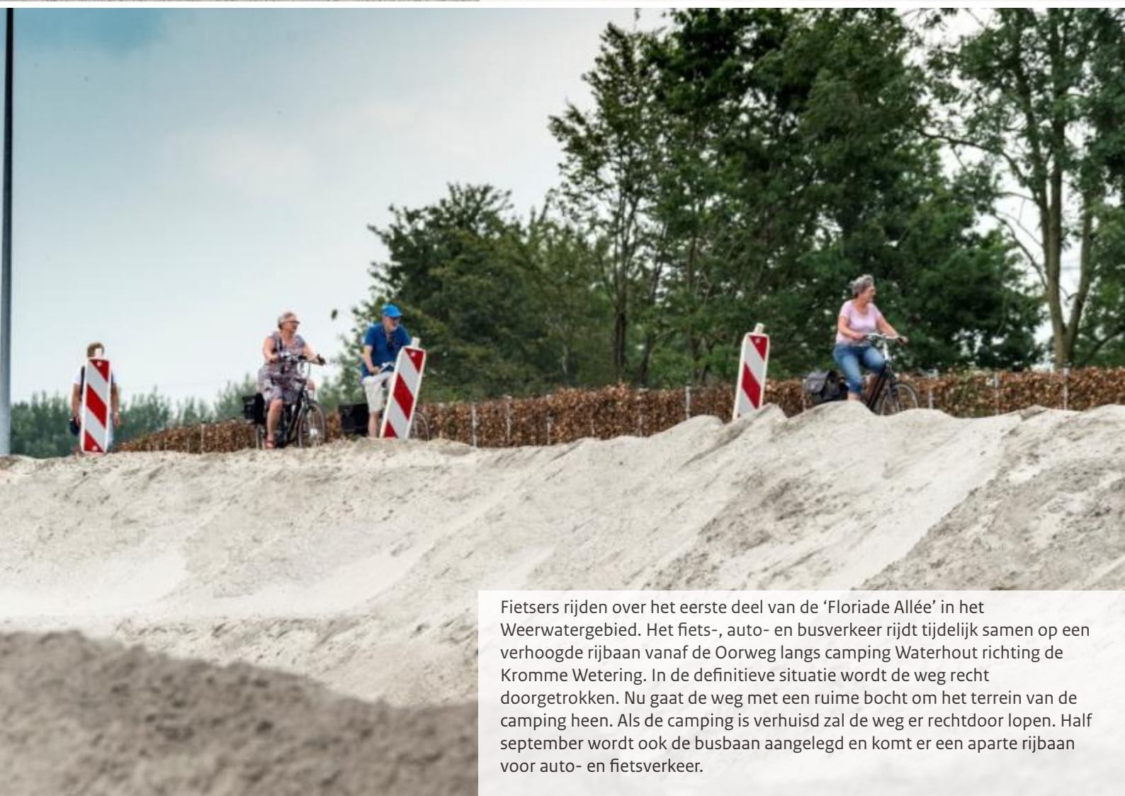
Bij het Weerwater gaat het lokale verkeer tijdelijk langs camping Waterhout over een opgehoogde weg: de Floriade Allée.
