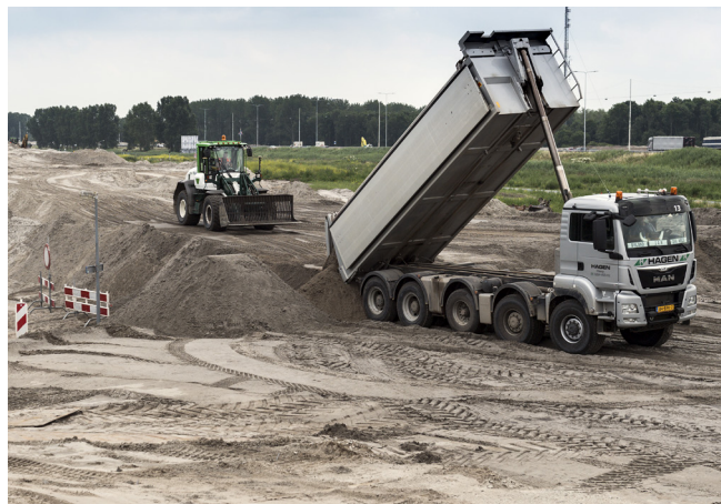
De verbreding aan de zuidkant van de A6 ter hoogte van het Weerwater.
