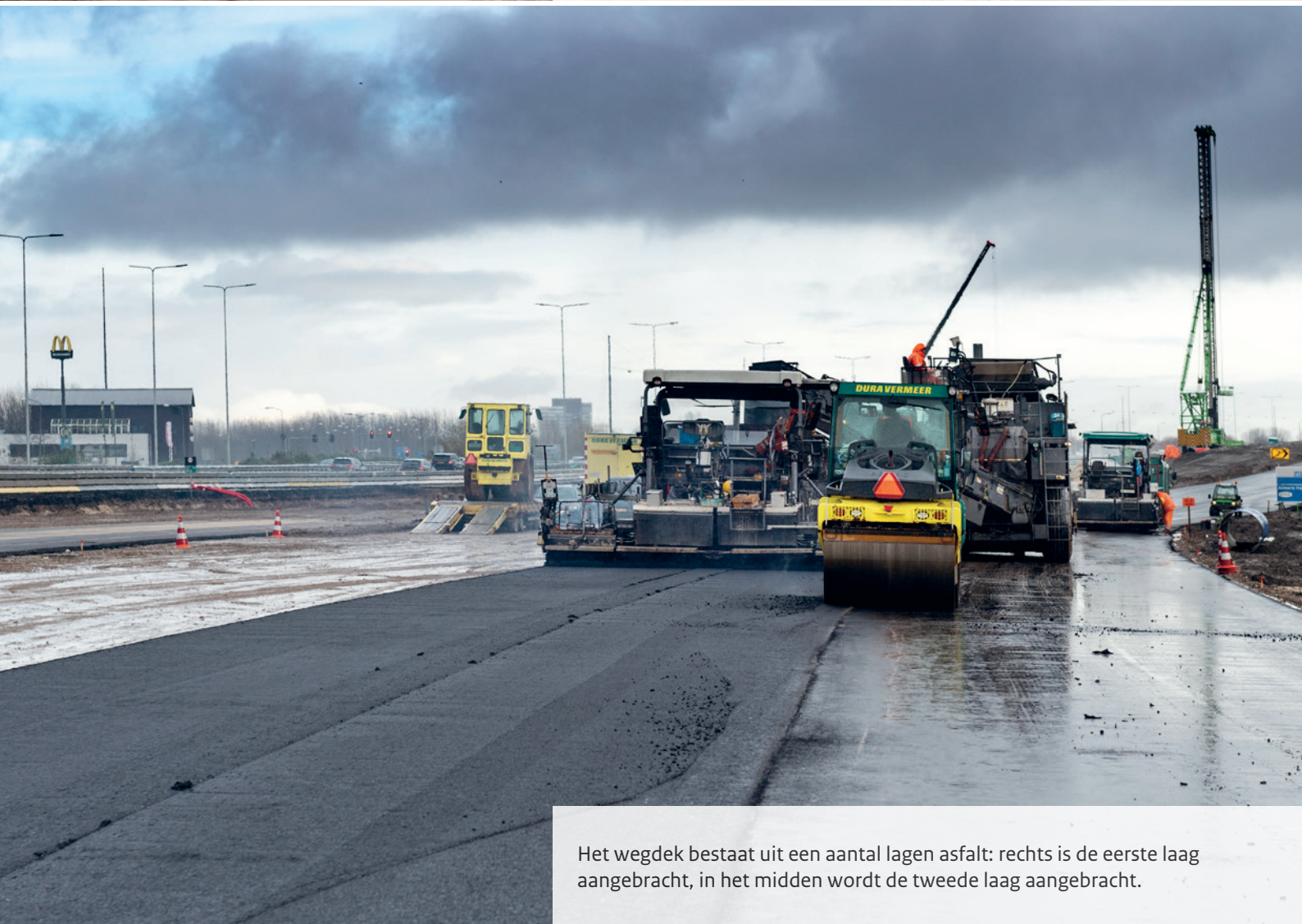
Aannemer Parkway6 asfalteert de nieuwe afrit.
