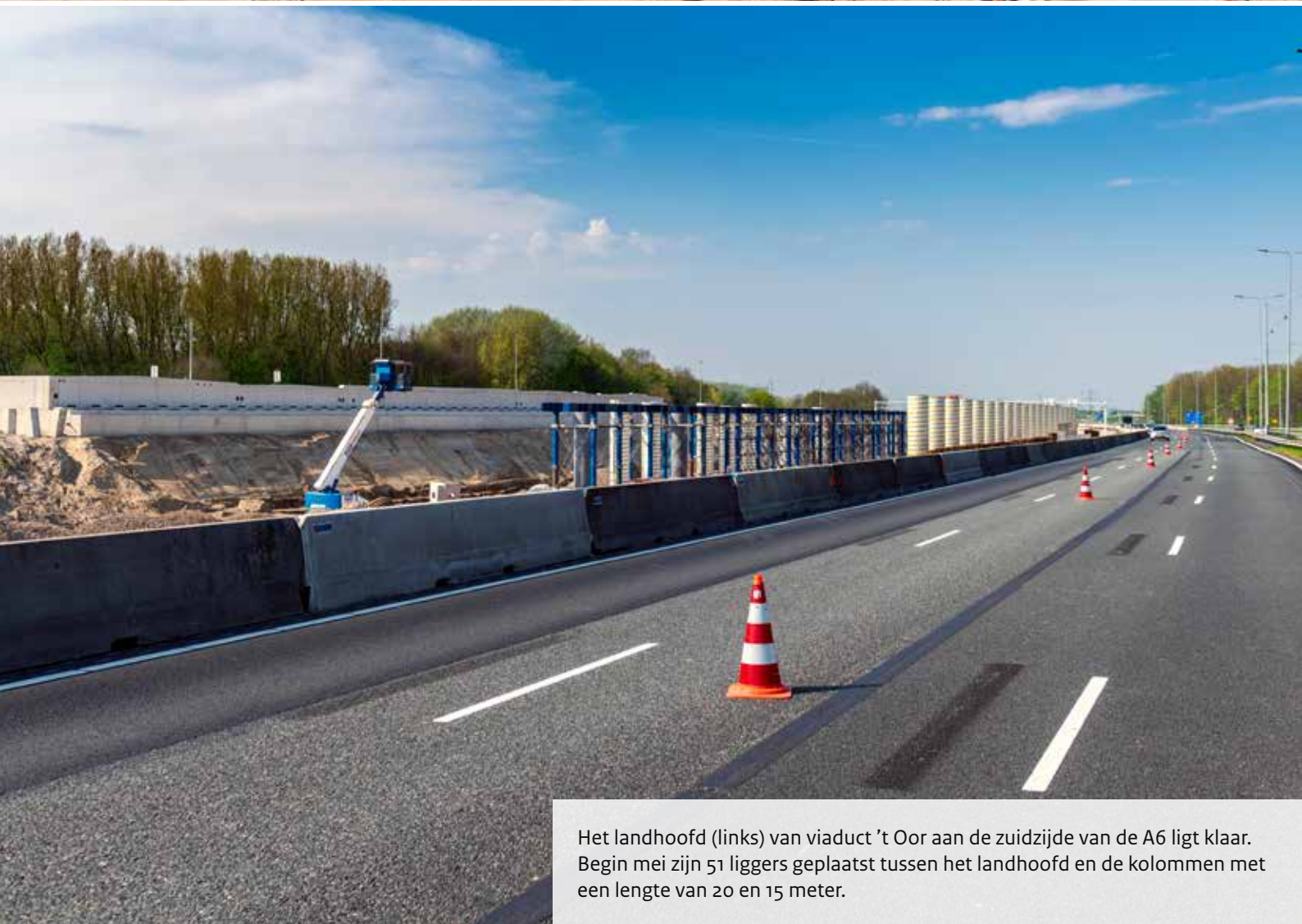
De kraan plaatst een tijdelijke constructie ter ondersteuning van de liggers. Liggers zijn betonnen balken die onderdeel zijn van de draagconstructie voor het wegdek van het viaduct.
