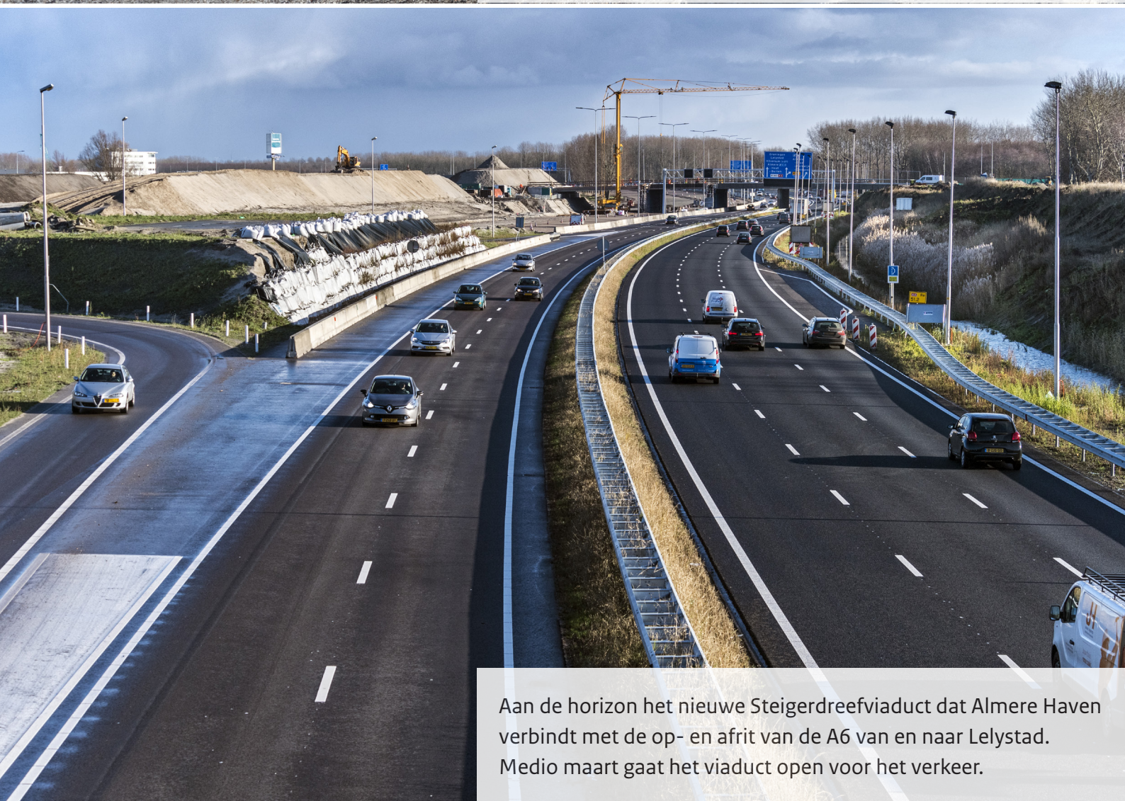
Dit deel van de nieuwe hoofd- en parallelrijbaan richting Amsterdam (Weerwatergebied) gaat in het voorjaar van 2019 open voor het verkeer.
