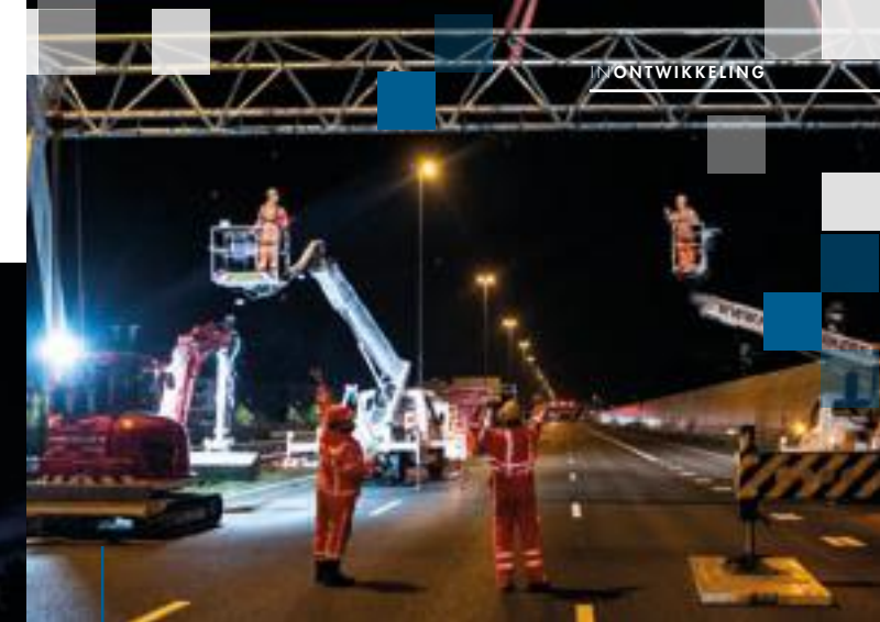
Ter hoogte van de Beneluxbaan is het bestaande portaal verwijderd en een nieuw, definitief portaal ingehesen, die straks over beide rijbanen gaat. Het portaal is maar liefst 62 meter breed. De A9 moest hiervoor afgesloten worden. Het afsluiten van een snelweg mag alleen in de nacht zodat het verkeer overdag kan blijven doorstromen. Vervolgens is de bebording opgehangen.
