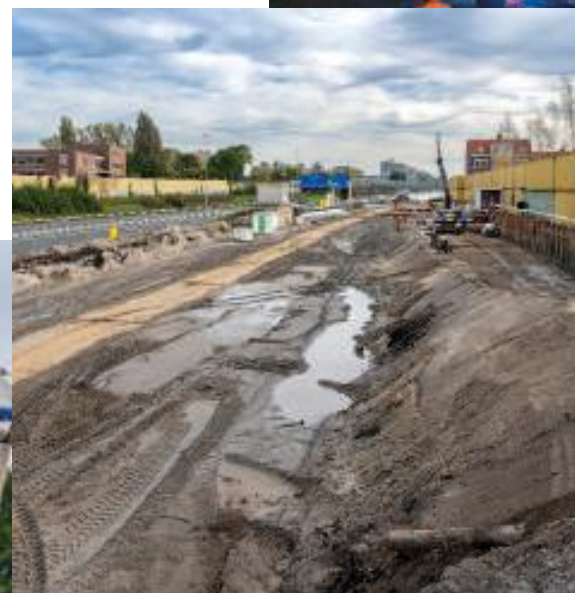
Bij de locatie waar de bypass komt te liggen ter hoogte van het Oude Dorp, is afgelopen weken 60.000 m3 zand afgegraven. Dit staat gelijk aan 6.000 zandwagens.
