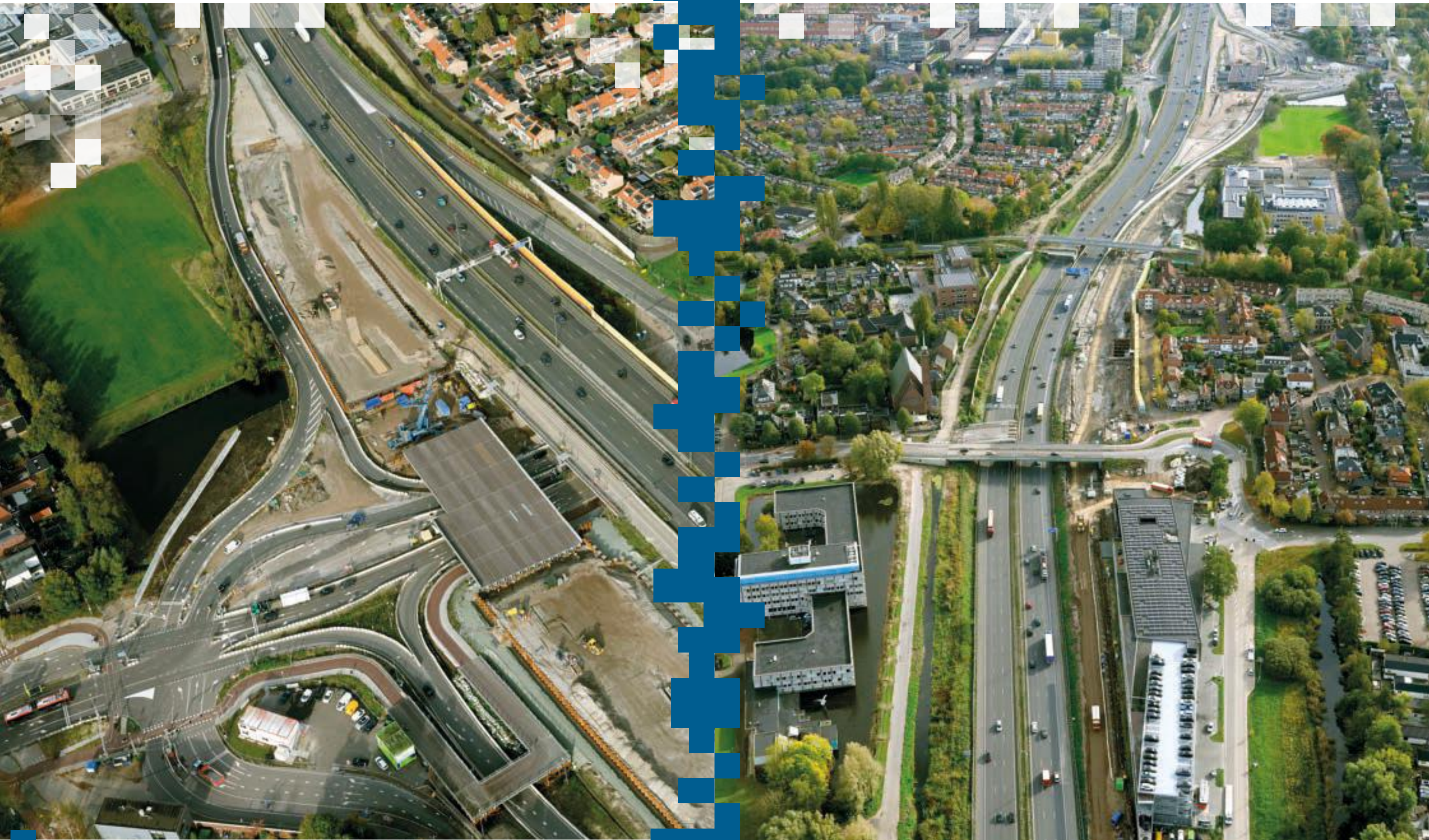
HET GROOTSTE TIJDELIJKE VIADUCT VAN NEDERLAND IN AANBOUW
