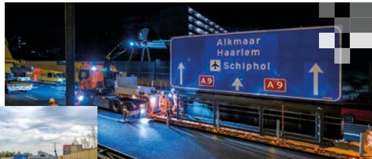
Ter hoogte van de Beneluxbaan is het bestaande portaal verwijderd en een nieuw, definitief portaal ingehesen, die straks over beide rijbanen gaat. Het portaal is maar liefst 62 meter breed. De A9 moest hiervoor afgesloten worden. Het afsluiten van een snelweg mag alleen in de nacht zodat het verkeer overdag kan blijven doorstromen. Vervolgens is de bebording opgehangen.
