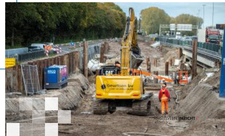
Ter hoogte van de Bleekerskade bij het Amsterdamse Bos wordt een hulpbrug gebouwd, als onderdeel van de bypass.
