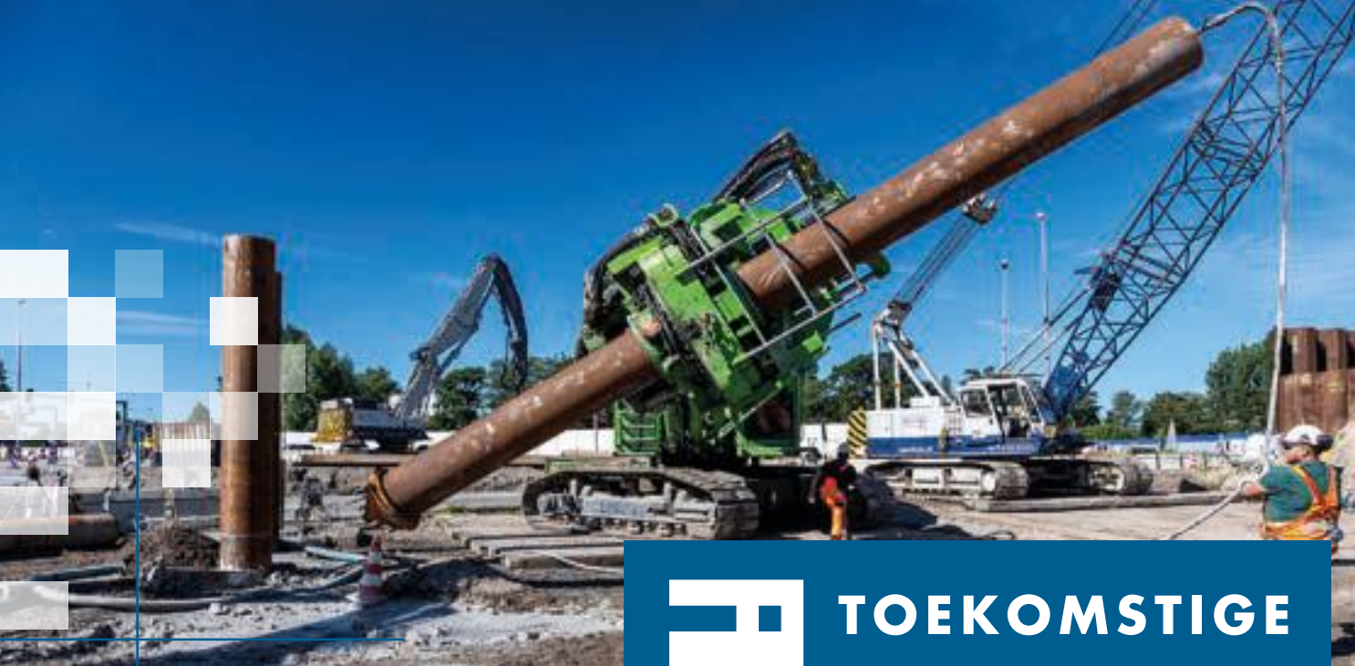
De buispalen voor de fundering van het grootste tijdelijke viaduct van Nederland worden aangebracht. In de palen zit een leiding zodat er vervolgens beton in gestort kan worden.
