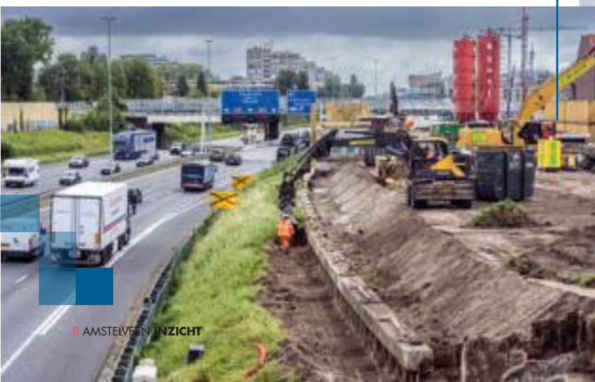
De bovenkant van de geluidschermen aan de zuidkant van de A9, ter hoogte van het Oude Dorp worden verwijderd. Vervolgens wordt de fundering (damwanden) weggehaald.
